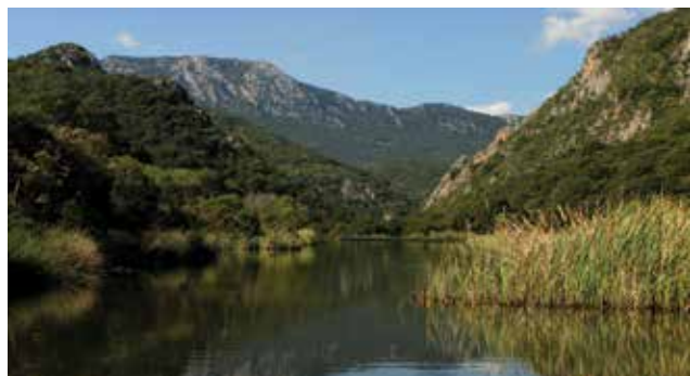
Il lago Corsi (Iglesias), costruito negli anni '60, contiene fino a 13 milioni di m 3 di acqua.
