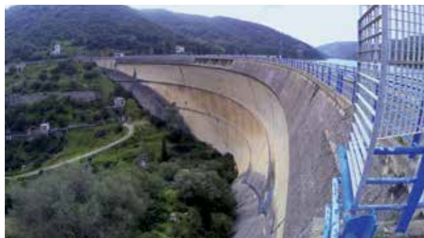
La diga sul fiume Cuga, in provincia di Sassari, ha una portata di 35 milioni di metri cubi.
